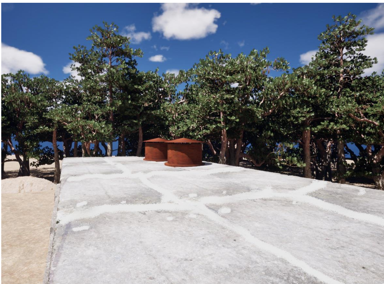
Заделка стыков, швов и трещин и незначительных разрушений для получения цельной поверхности основания.
